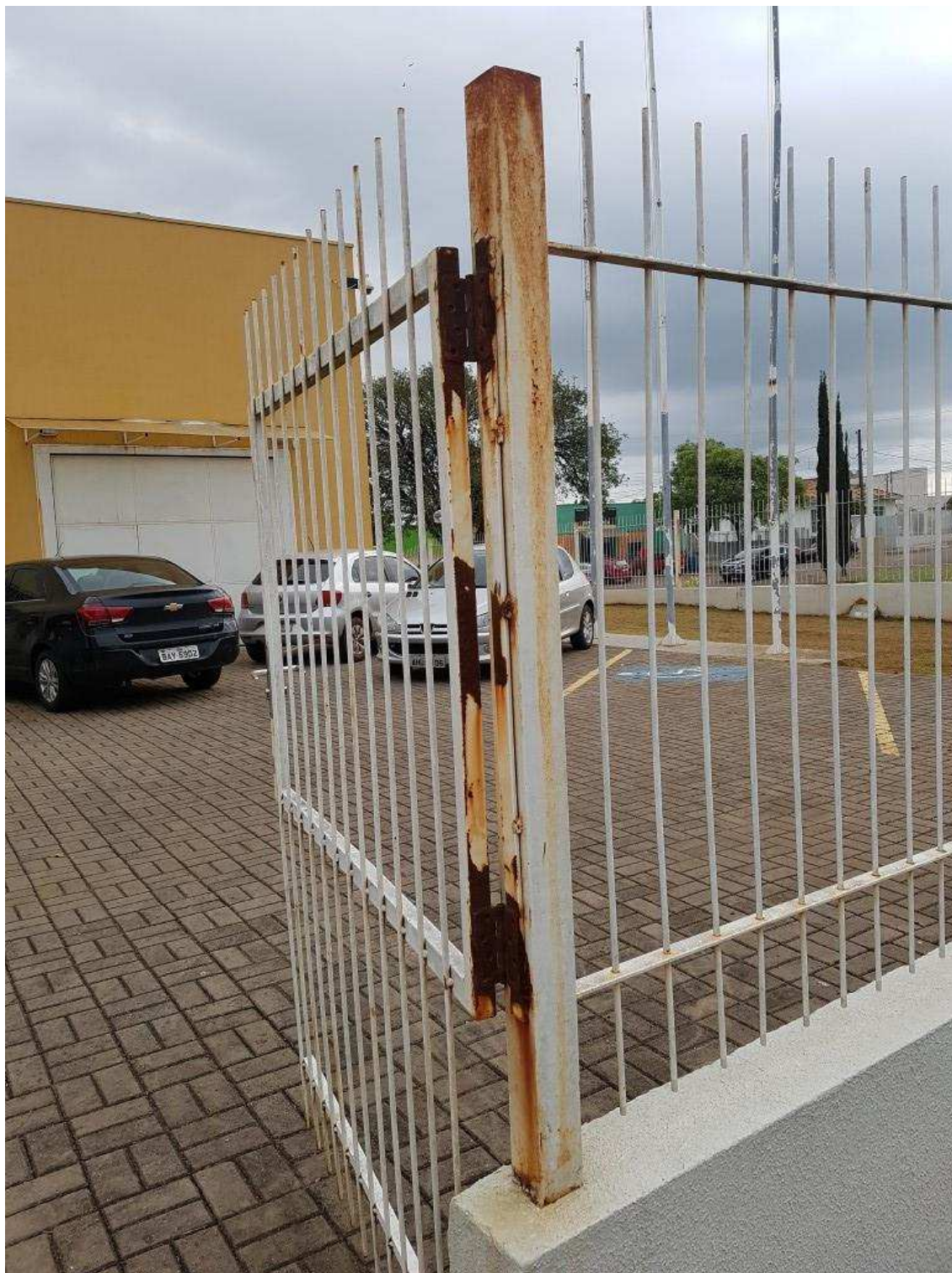
Corrosão nas grades externas
