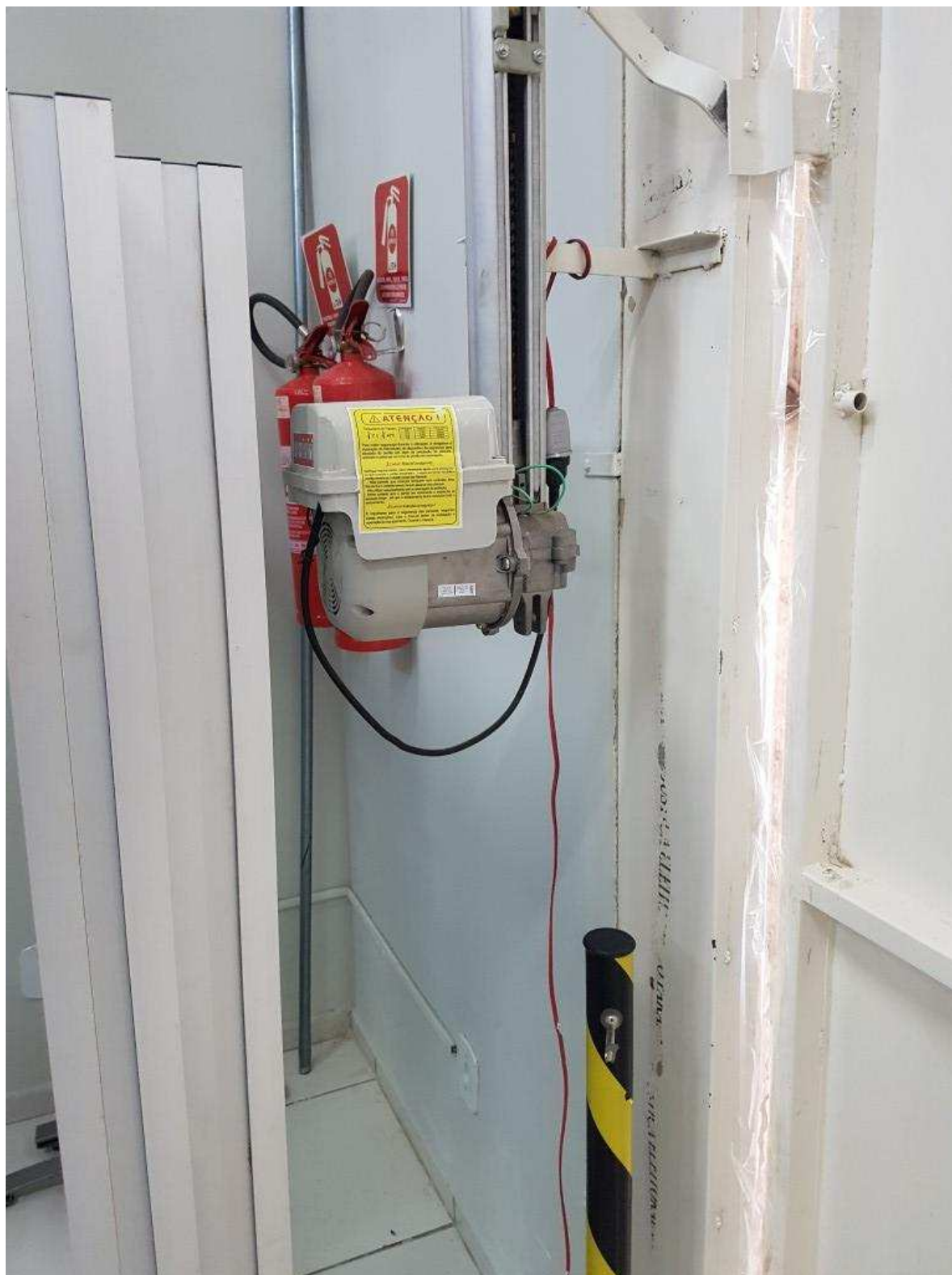
Motor do portão do depósito de urnas
