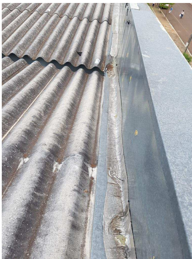
Manta aluminizada acima do contra rufo – solução paliativa
