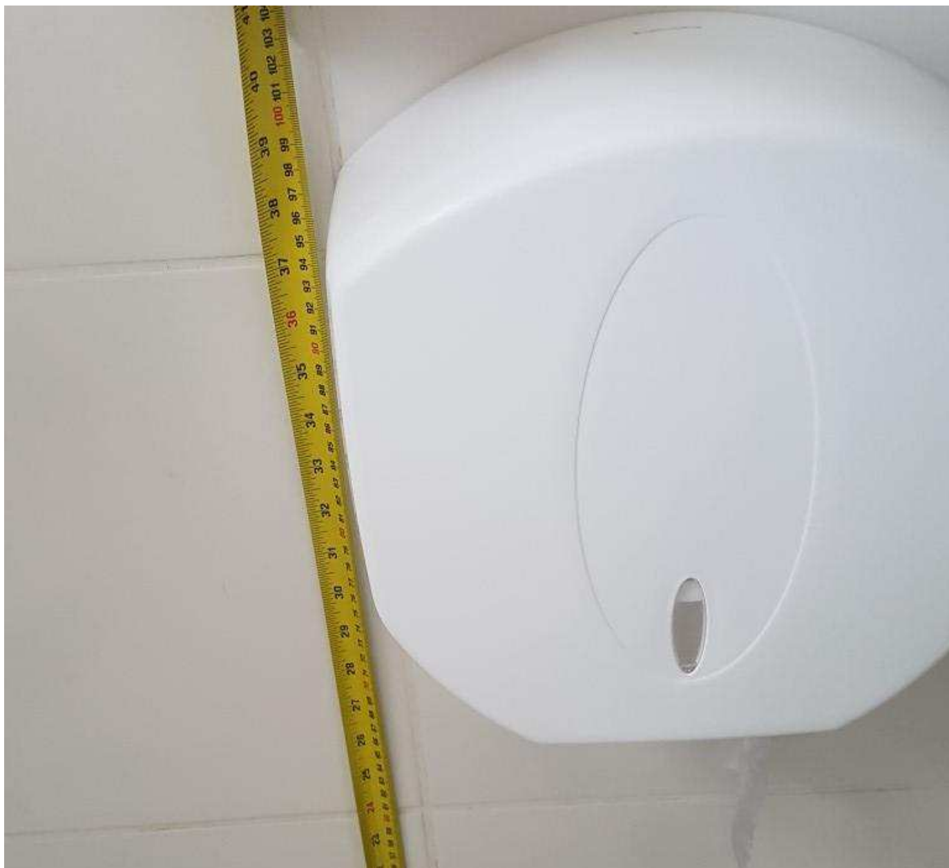
Altura da colocação da papeleira em desconformidade com a norma
