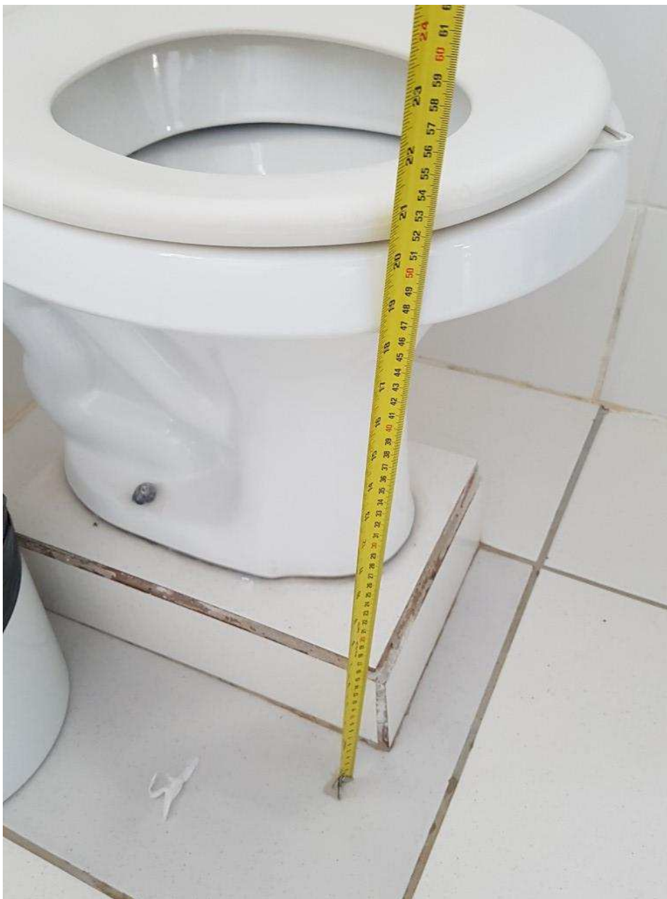
Altura do vaso sanitário em desconformidade com a norma
