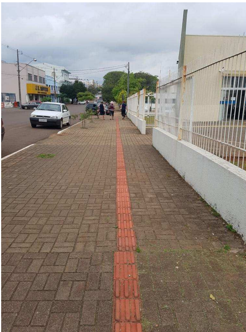
Calçamento em frente ao Fórum. Piso tátil desalinhado
