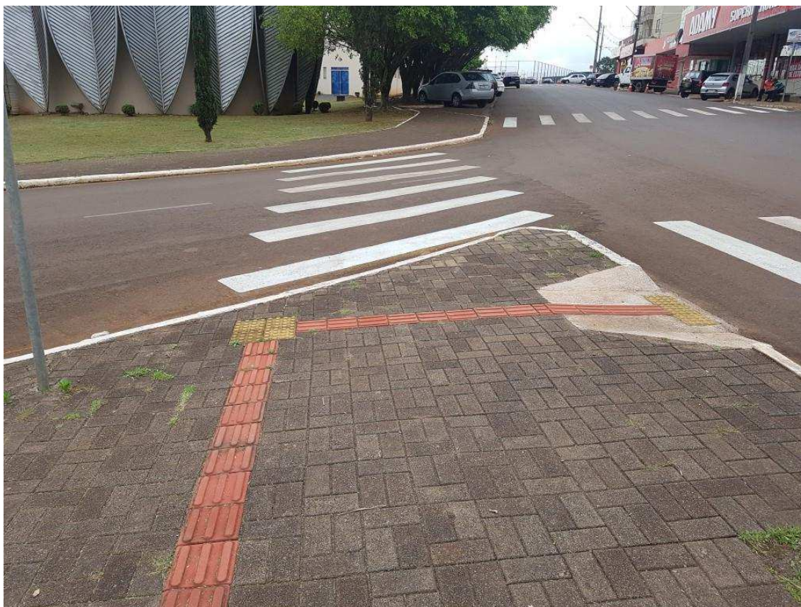
Calçamento na esquina do fórum. Mudança de sentido em desacordo com a norma
