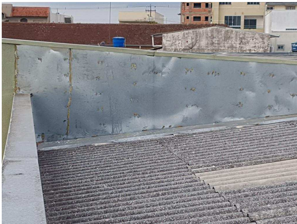
Chapas metálicas na platibanda com cortes e ausência de vedação
