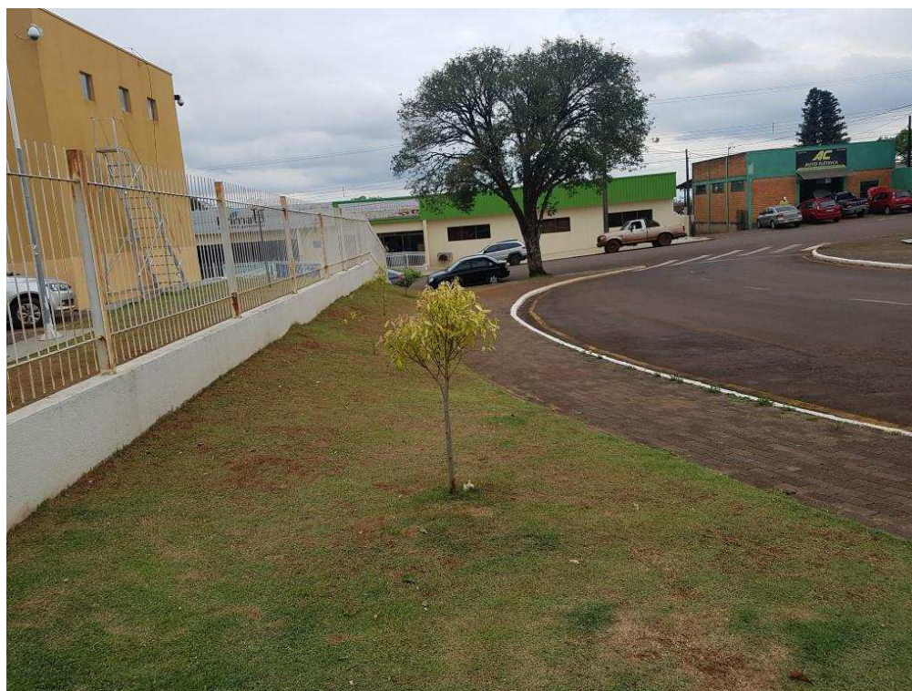
Calçamento lateral sem piso tátil
