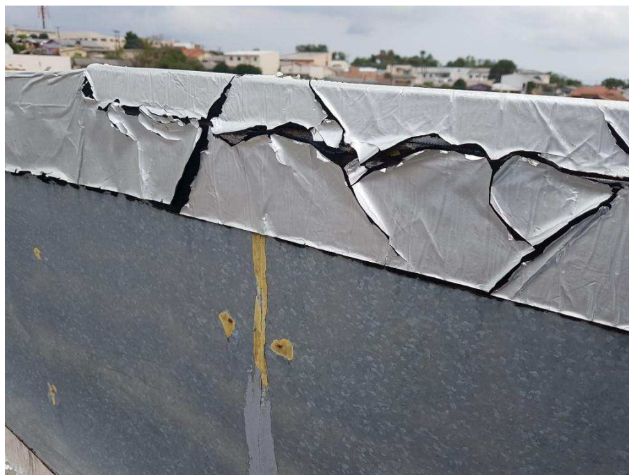
Manta aluminizada acima do rufo – solução paliativa
