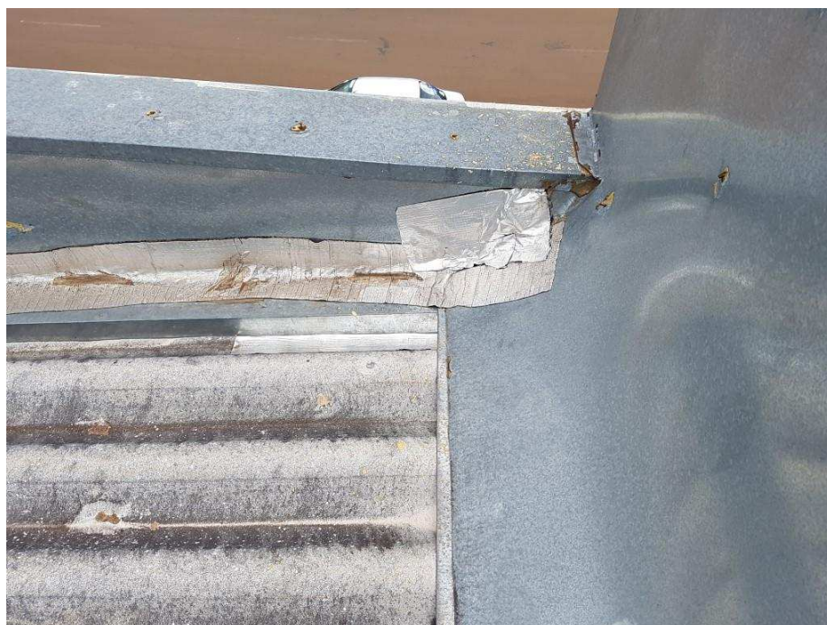
Manta aluminizada acima do contra rufo – solução paliativa
