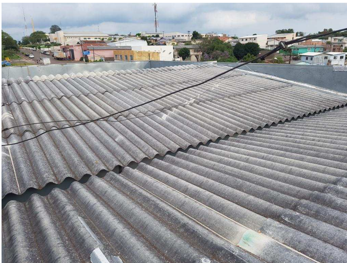
Cobertura. Algumas telhas trincadas com manta acima – manutenção paliativa
